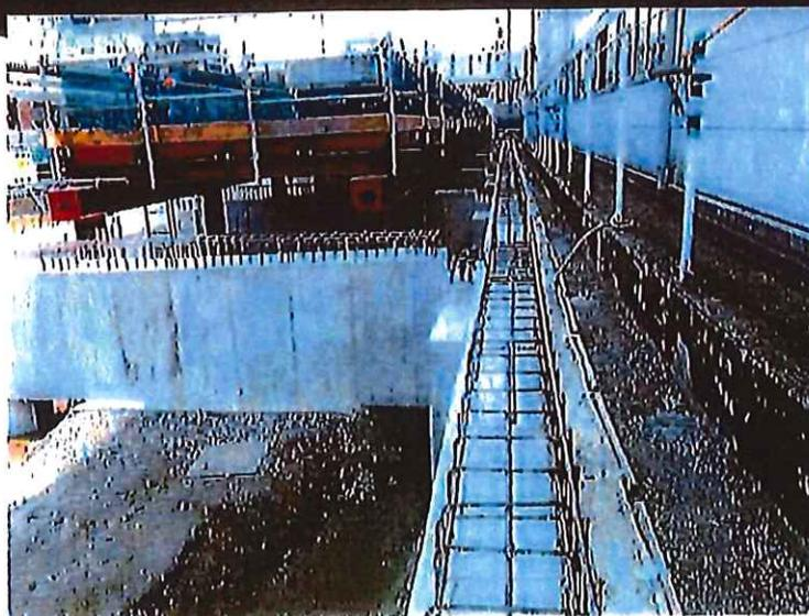
▶ 基礎コンクリート打設完了
